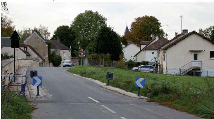
Aménagement d'une chicane route de Villers
