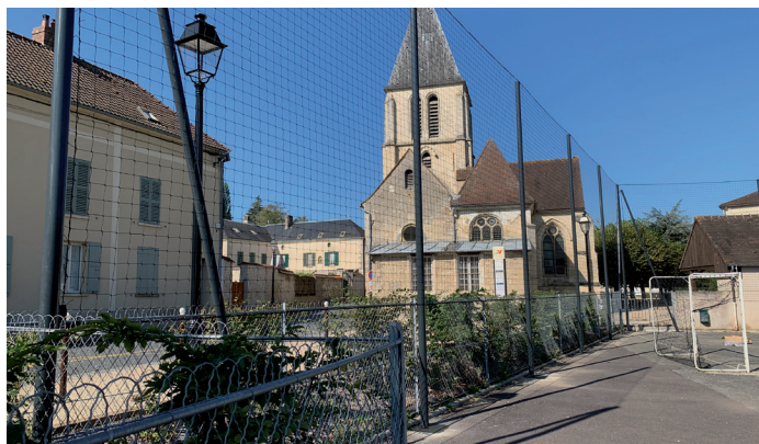
Filets pare-ballons autour du terrain sportif
